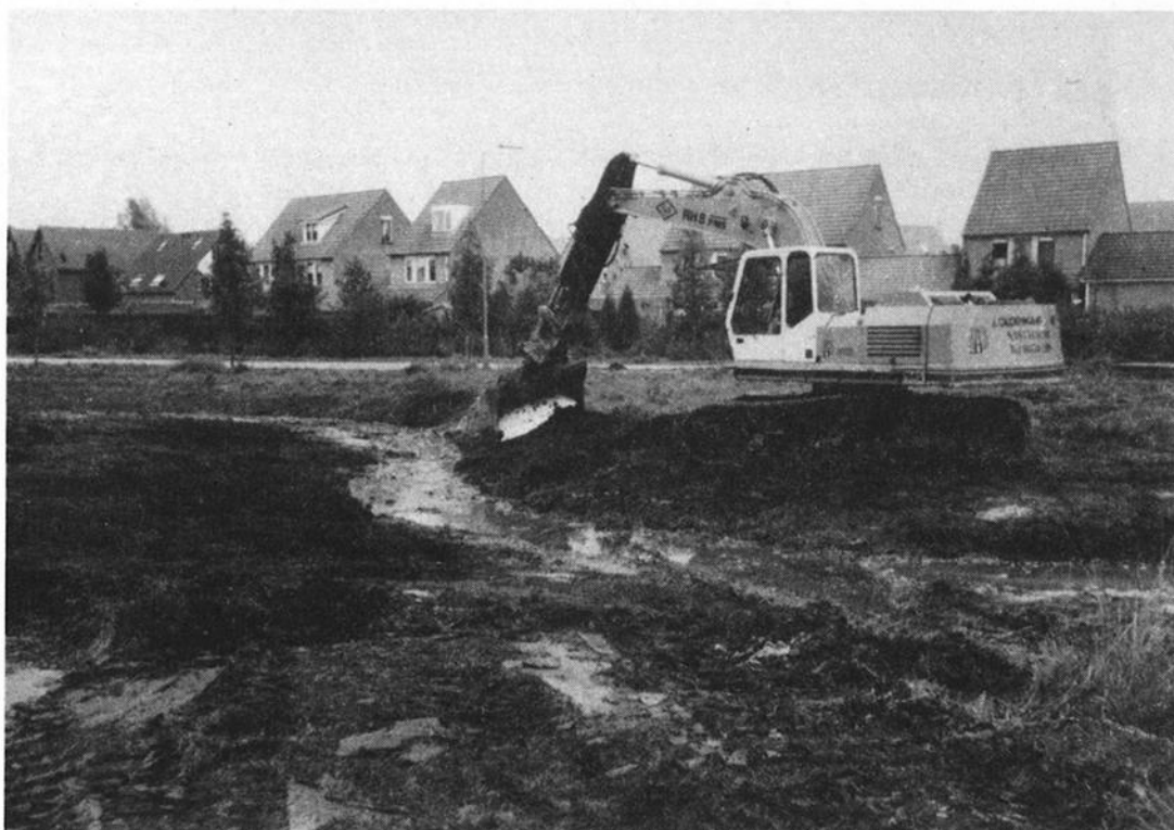
Foto 4. Het graven van de meander in de Drulse Beek.
